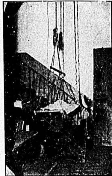
Il montacarichi The hoist
